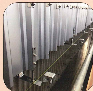
③全ネジボルトで樋の 上下・前後の位置を 調整し固定する
