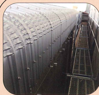
②軒先側(刻印側)より ドリルビス2本を使用 し取り付ける
